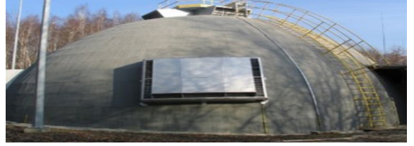
Görsel 9.2. Patlama sığınağı.
