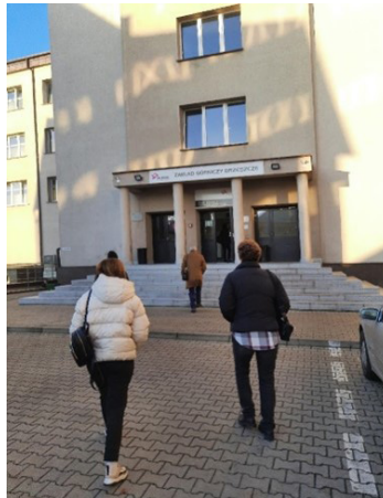
Görsel 8.1. Brzeszcze Madencilik Tesisini maden kurtarma istasyonu görüntüsü.
